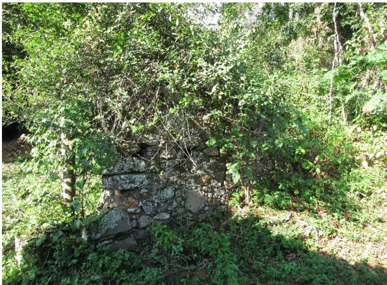
Figura 10.2 – Fazenda da Tapera da Barra do Sul. Parede em pedras argamassadas da senzala da antiga fazenda
