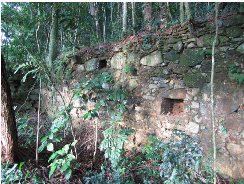
Figura 10.3 – Fazenda da Tapera da Barra do Sul. Parede em pedras argamassadas do alambique da antiga fazenda
